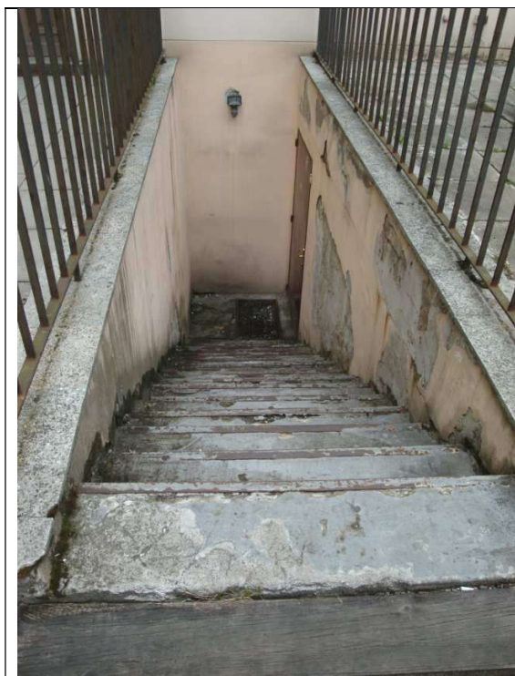
Fot. 11 Widok schodów zejściowych do piwnicy. Stan zniszczenia wszystkich stopni identyczny, warstwa zabezpieczająca stopnie betonowe w znacznej części uległa detrukcji.
