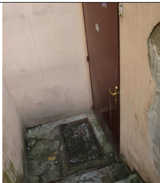
Fot. 14 Podest dolny ze śladami stojącej wody deszczowej oraz zanieszyczoną kratą i niedrożnym odpływem wody deszczowej
