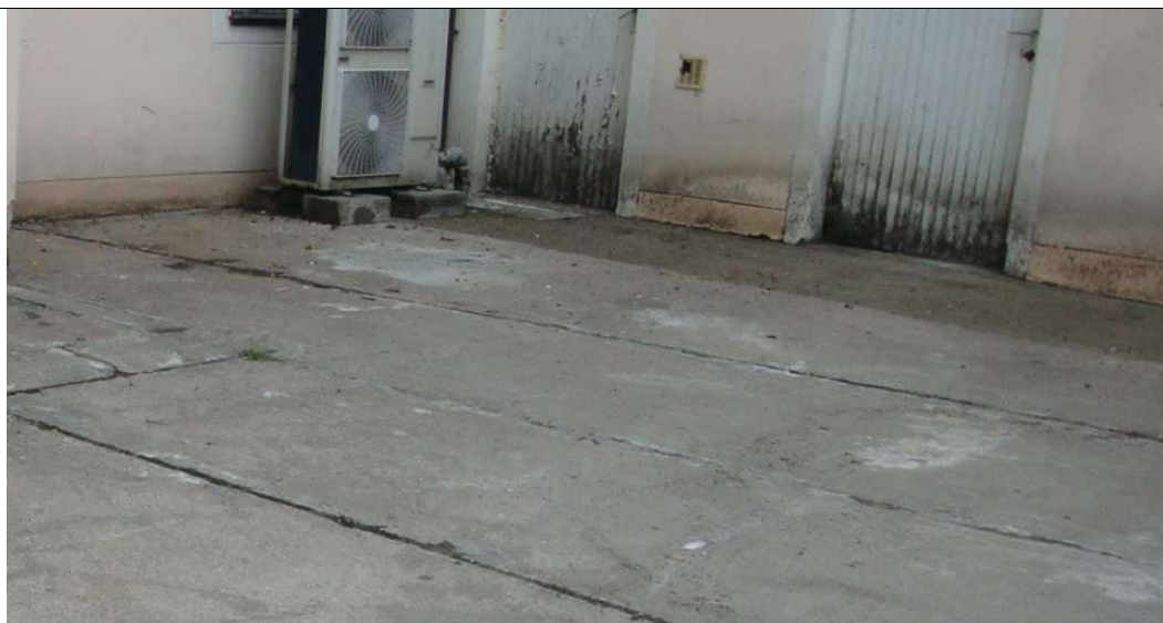
Fot. 4 Elewacja od dziedzińca – widoczne zawilgocenie tynku, pas cokołowy mokry i zniszczony
