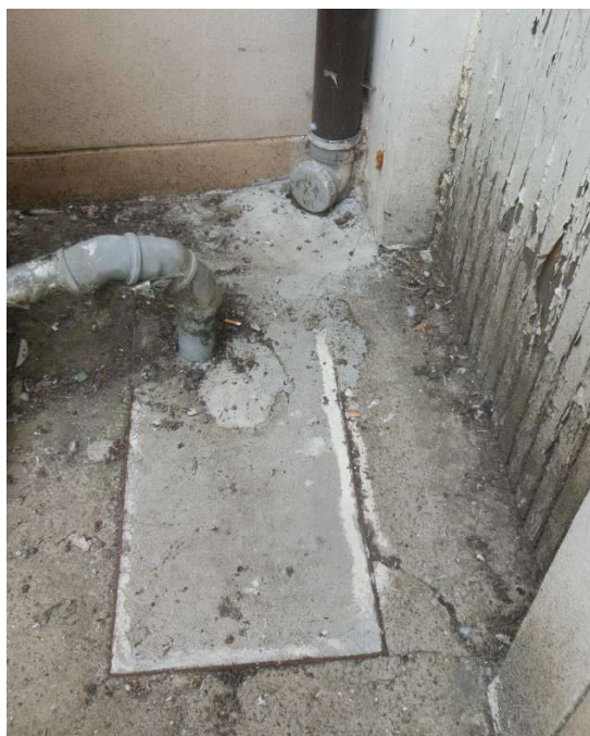
Fot. 17 Przejście rury urządzeń klimatyzacyjnych przez płytę stropu nad piwnicą
