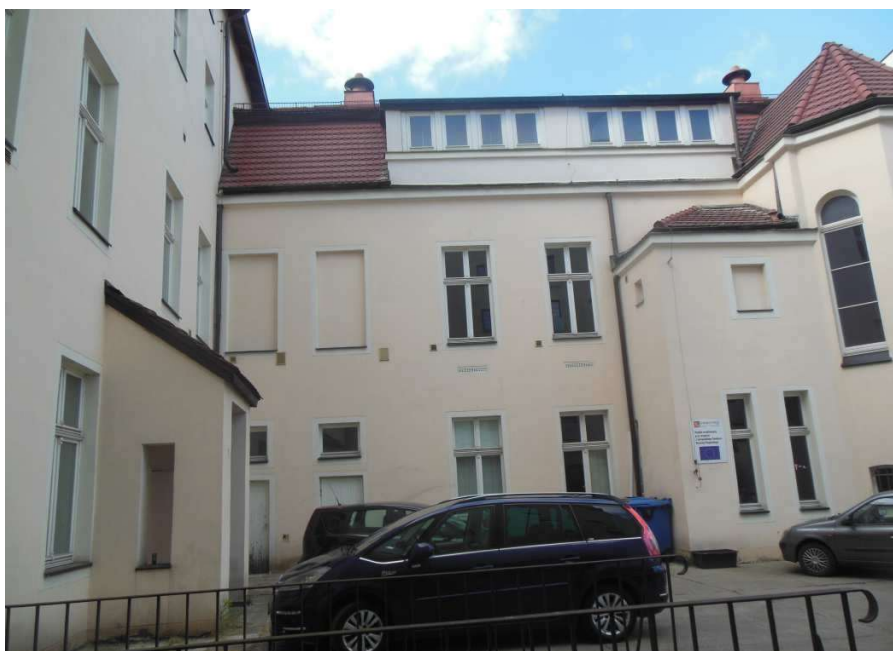
Fot.3 Widok elewacji od strony dziedzińca wewnętrznego
