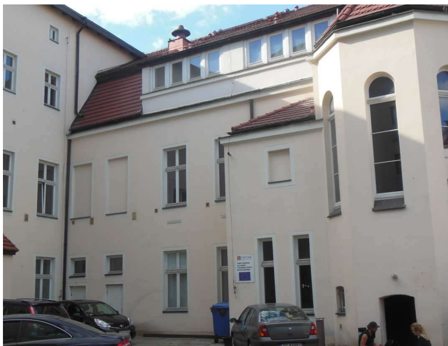
Fot 2 Widok elewacji od strony dziedzińca wewnętrznego
