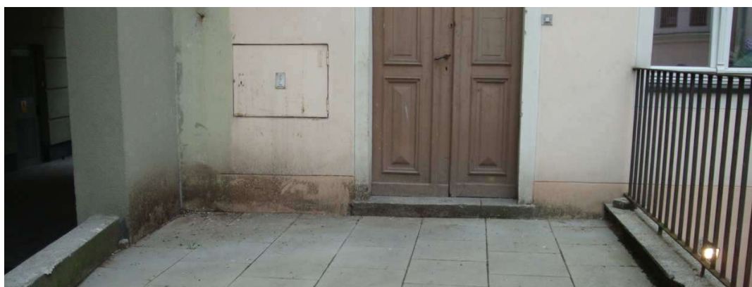
Fot. 7 Naroże ściany dziedzińca – zabrudzenia, zawilgocenie tynku, mokry pas cokołowy. Wyraźnie widoczny wadliwie wykonany spadek chodnika w stronę naroża.
