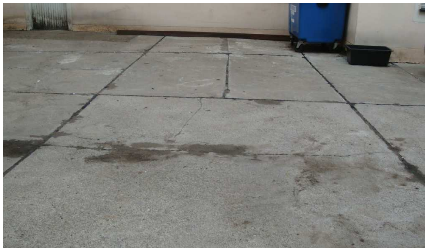
Fot. 19 Wierzchnia warstwa płyty parkingowej na stropie nad piwnicą. Widoczne pęknięcia płyt pomiędzy dylatacjami.
