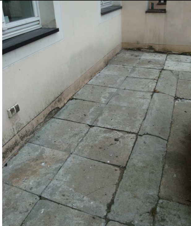
Fot. 4 Elewacja od dziedzińca – widoczne zawilgocenie tynku, pas cokołowy mokry i zniszczony
