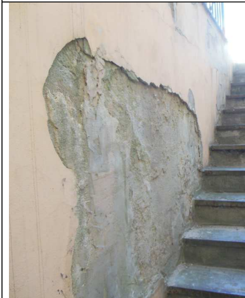
Fot. 15 Ściana przy schodach zejściowych do piwnicy częściowo pozbawiona tynku
