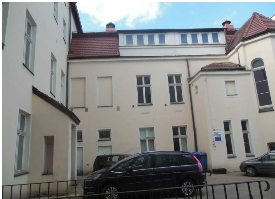
Fot.3 Widok elewacji od strony dziedzińca wewnętrznego
