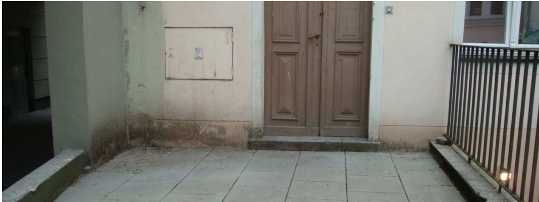
Fot. 7 Naroże ściany dziedzińca – zabrudzenia, zawilgocenie tynku, mokry pas cokołowy. Wyraźnie widoczny wadliwie wykonany spadek chodnika w stronę naroża.
