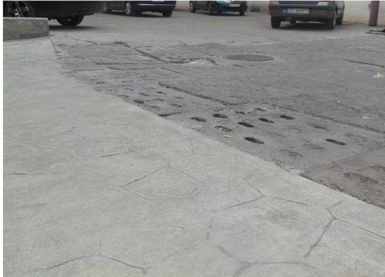
Fot. 22 Płyty jomb stanowiące warstwę wierzchnią parkingu na gruncie zużyte, miejscami zapadnięte
