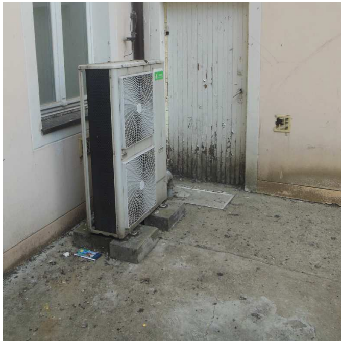
Fot. 8 Zniszczenie drzwi wejściowych do budynku w wyniku rozbryzgów wody opadowej
