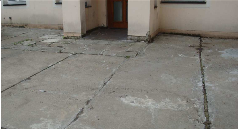
Fot. 6 Wejście do budynku – tynkowany pas cokołowy częściowo odspojony, zabrudzony i zawilgocony
