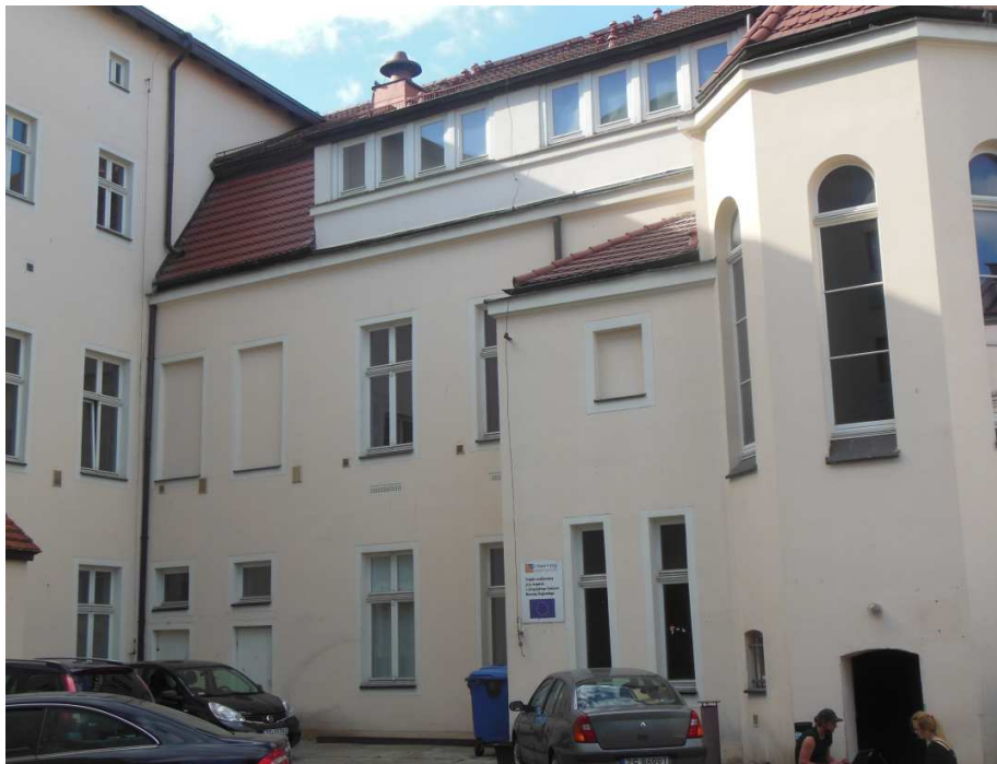
Fot 2 Widok elewacji od strony dziedzińca wewnętrznego
