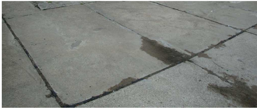
Fot. 20 Ogólne zużycie warstwy wierzchniej stropu nad piwnicą. Wykruszony materiał izolacyjny szczelin dylatacyjnych między płytami.
