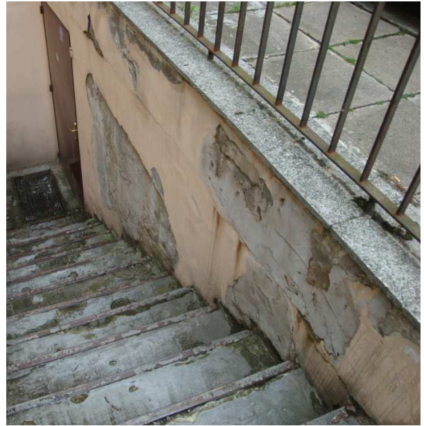
Fot. 12 Widok ściany bocznej zejścia. Braki tynku, zawilgocenie.
