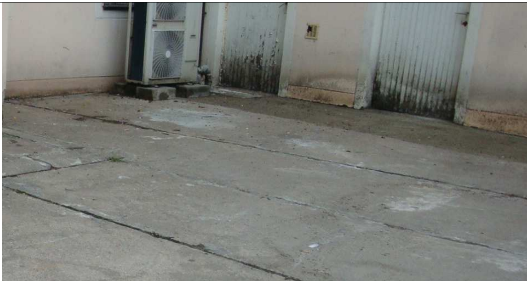
Fot. 4 Elewacja od dziedzińca – widoczne zawilgocenie tynku, pas cokołowy mokry i zniszczony
